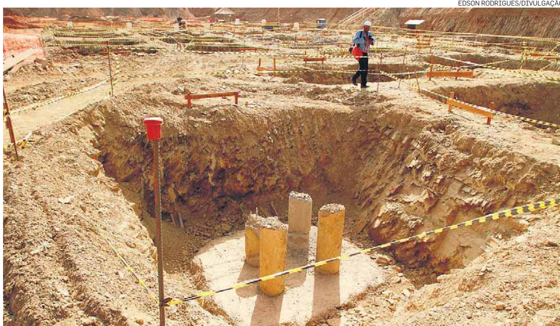
Em Cuiabá. Ainda nas fundações, Arena Pantanal será erguida com viés de sustentabilidade
